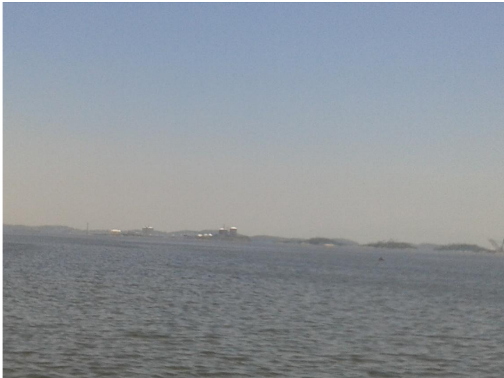
Foto 04: Instalações dos Terminais da Ilha Comprida e Ilha Redonda.
